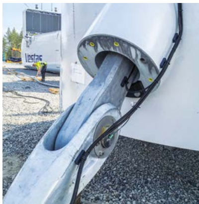
TRUpin - permanente Messung und Überwachung der Seilkraft.
