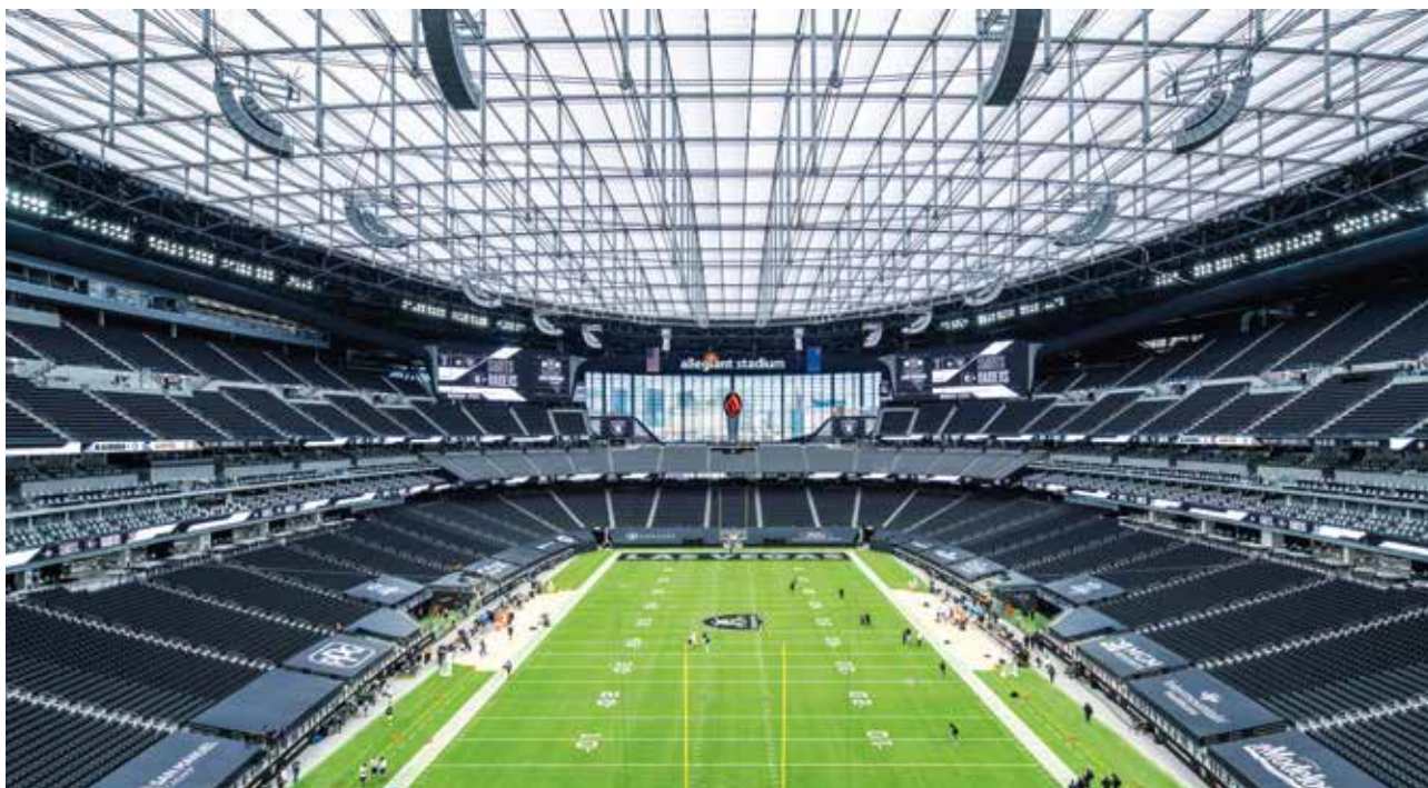
Das neuartige ETFE-Dachsystem sorgt für eine natürliche Beleuchtung und schützt vor Witterungseinflüssen.
