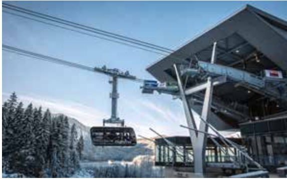
© Bayerische Zugspitzbahn Bergbahn AG
