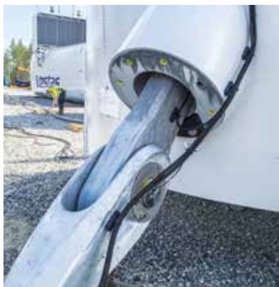
TRUpin – mesure et surveillance permanentes de la tension du câble.
